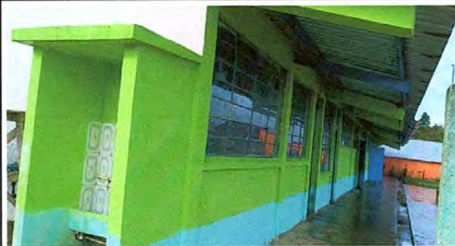
Foto 4: Trabajo terminado sobre la pintada de las aulas del centro educativo.
