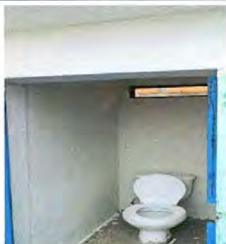
Foto 7: Trabajando en la reparación del repello de baños (3 baños)
