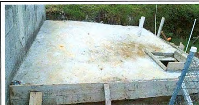
Foto 6: Trabajo terminado sobre reparación y mantenimiento de cisterna/depósito de agua (cambio de paredes de block a concreto con repello)
