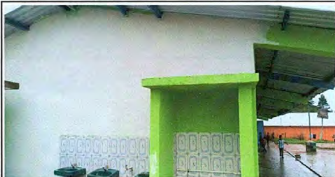
Foto 1: Trabajo terminado sobre el impermeabilizante a la pared del aula tecnológico.
