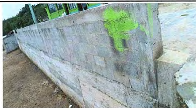
Foto 8: Trabajo terminado de la reparación del muro de contención del centro educativo.
