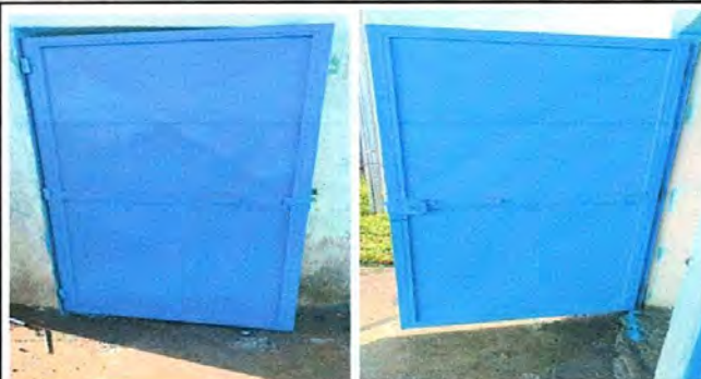
Foto 2: Trabajo terminado de la reparación de las puertas y chapas del baño.
