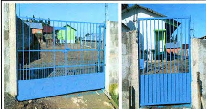
Foto 3: Trabajo terminado de la reparación y sustitución del portón.
