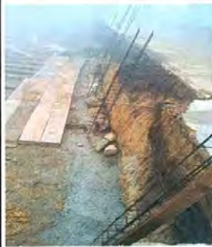
Foto 8: Trabajo terminado en la reparación del muro de contención del centro educativo.
