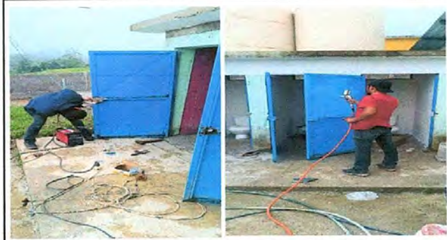
Foto 2: En proceso de reparación de las puertas y chapas del baño.
