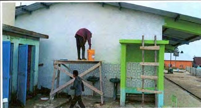
Foto1: Colocando el impermeabilizante a la pared del aula tecnológico.
