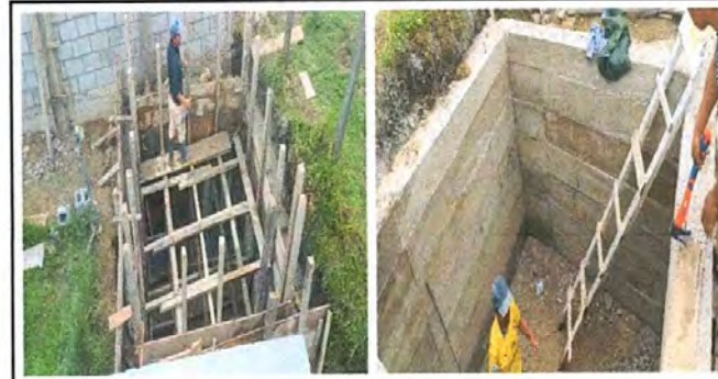
Foto 6: En proceso de trabajo sobre reparación y mantenimiento de cisterna/depósito de agua (cambio de paredes de block a concreto con repello)
