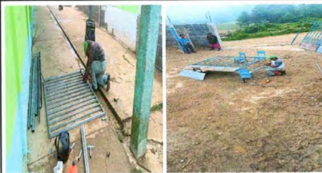
Foto 3: En proceso de reparación y sustitución de portón de metal.
