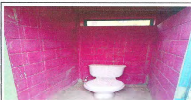
Foto 6: Reparación de repello baños (3 baños)
