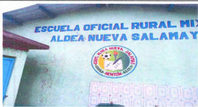
Foto 1: Impermeabilización de pared aula tecnológico
