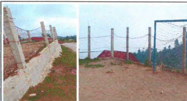
Foto 4: Reparación de la circulación del centro educativo
