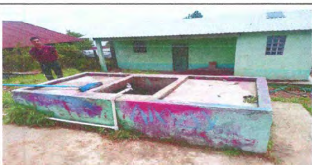
FOTO 5: Reparación y mantenimiento de cisterna/depósito de agua (cambio de paredes de block a concreto con repello)
