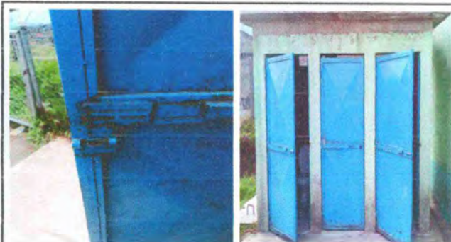
Foto 2: Reparación y sustitución de puertas de baño y chapas
