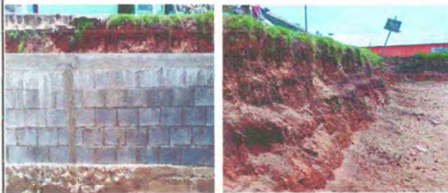
Foto 7: Reparación del muro de contención (foto 1 trabajo hecho por la comunidad, foto 2 trabajo pendiente del muro de contención)
