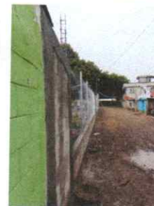
Foto 6: Reparación de muro perimetral de block con tubo hg y malla galvanizada, soleras intermedias y columnas.
