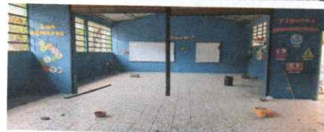
Foto 4: Sustrucción de piso de cemento líquido.
