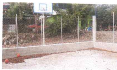
Foto 6: Reparación de muro perimetral de block con tubo hg y malla galvanizada, soleras intermedias y columnas.
