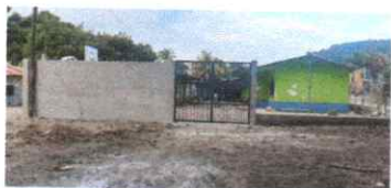
Foto1: Sustrucción de portón de metal.
