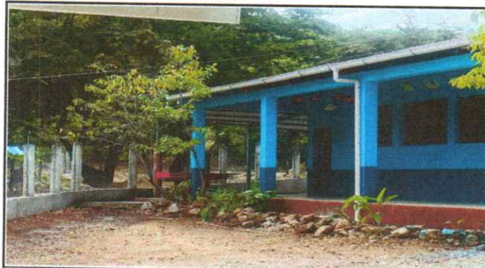
Foto 4: Bajada de agua pluvial instalado.
