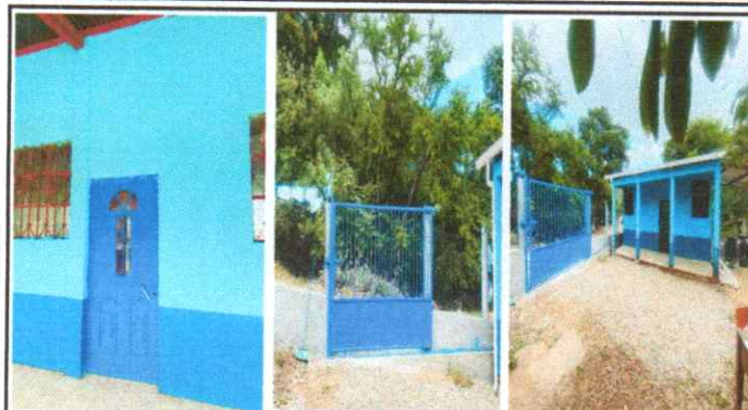
Foto 2: Puerta, Porton de metal y Pintura terminado.
