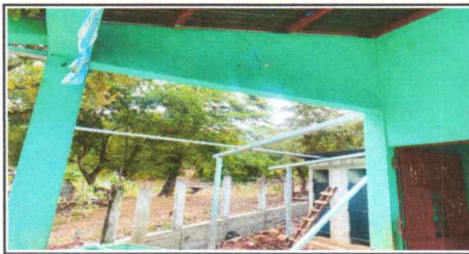
Foto 5: Reparación de techo.
