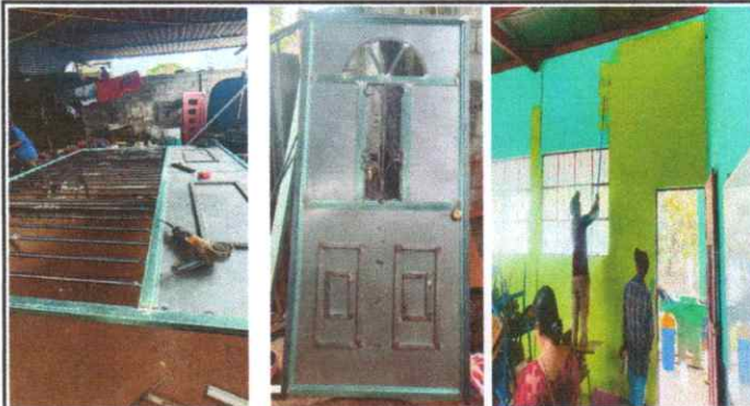
Foto 2: Sustitución de puerta, mantenimiento a porton de metal y Pintura en muros.
