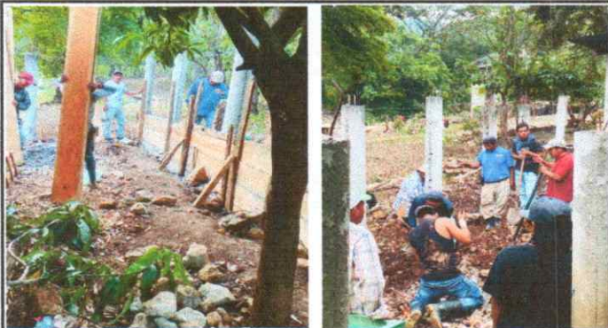
Foto 1: Reparación de Muro Perimetral
