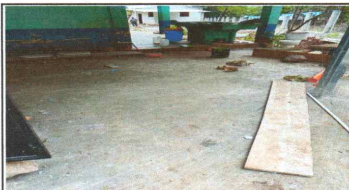
Foto 3: Reparación de piso.
