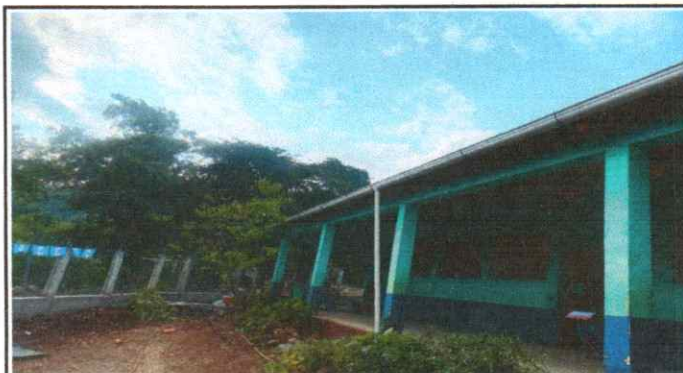
Foto 4: Sustitución de bajada de agua pluvial.
