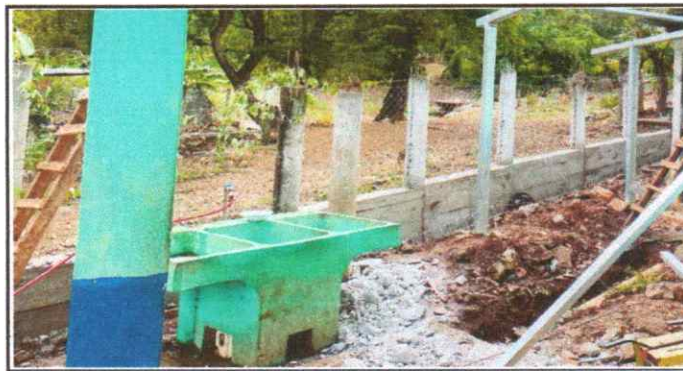
Foto 6: Sustitución de pila.
