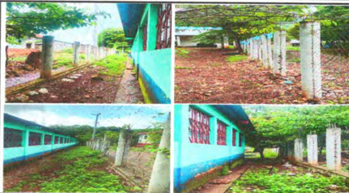
Foto 1: Reparación de Muro Perimetral
