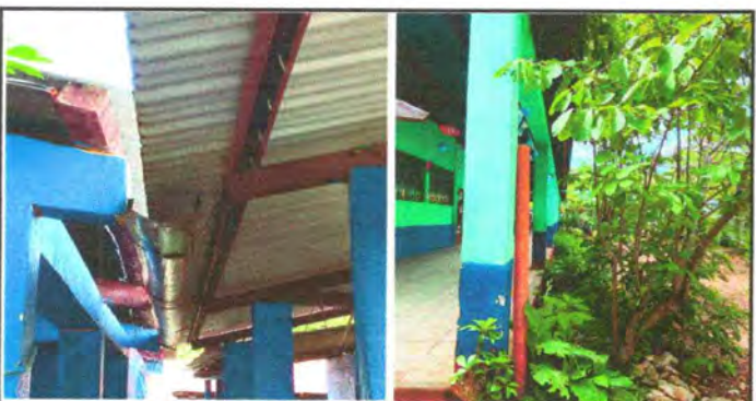
Foto 5: Sustitución de canal
