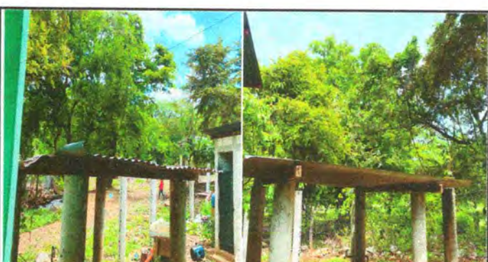
Foto 6: Sustitución de estructura de soporte de madera
