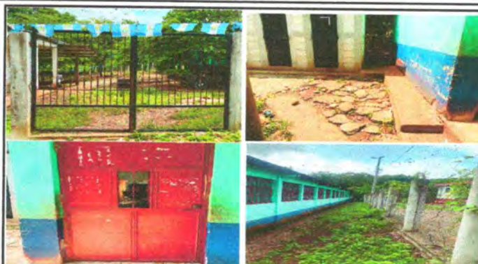
Foto 2: Sustitución de puertas de metal.
