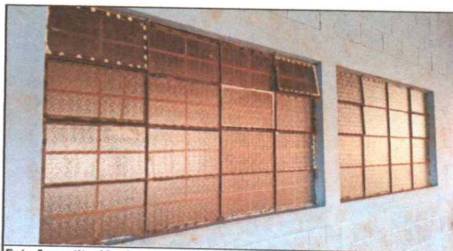
Foto 6: sustitución de vidrios de ventanas culminado
