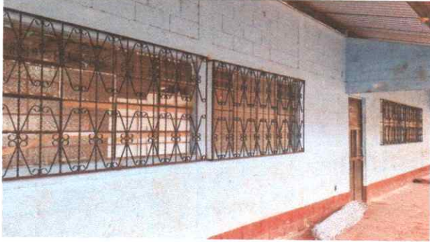
Foto7: balcones de aulas culminado
