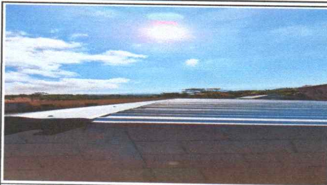
Foto 2: lamina y capote culminado.
