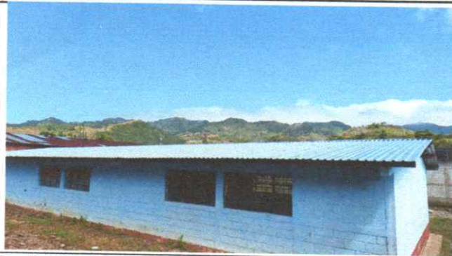
Foto1: lamina y capote culminado
