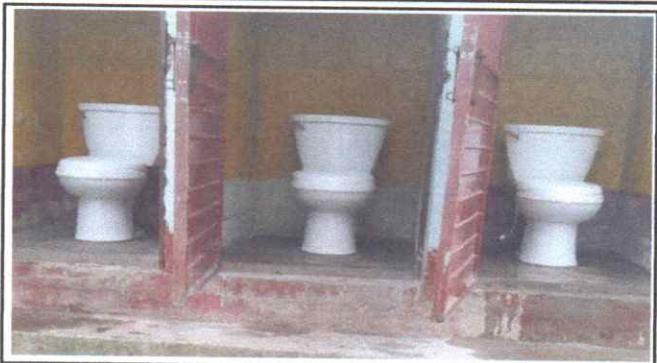
Foto 8: instalación de inodoros culminado
