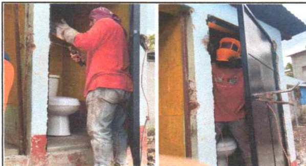
Foto 4: en el proceso del cambio de puerta de metal en servicios sanitarios
