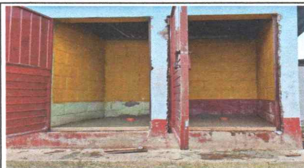
Foto 8: en el proceso sustitución de inodoros
