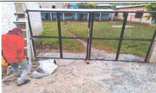
Foto 3: en el proceso del cambio de portón
