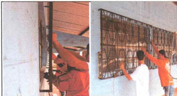
Foto 7: en el proceso de sustitución de balcones de metal
