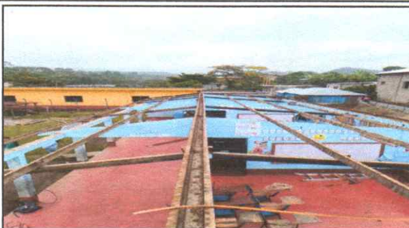
Foto 2: proceso cambio de lamina y capote
