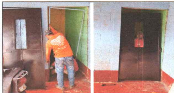
Foto 5: en el proceso del cambio de puerta de metal en el aula.
