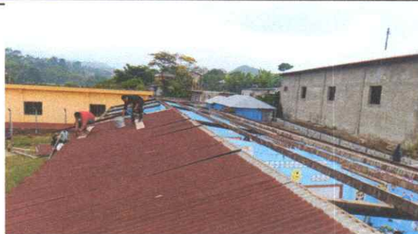
Foto 1: proceso cambio de lamina y capote
