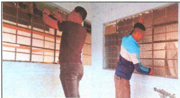
Foto 6: en el proceso del cambio de vidrios de ventanas en las aulas.
