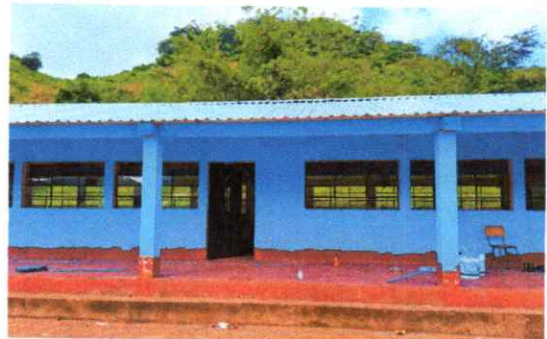
Foto 4: Pintura en muros exteriores e interiores
