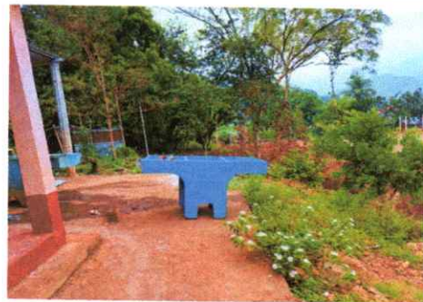
Foto 6: Reparación de cocina
