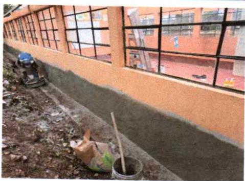
Fotografía 7: Reparación de repello y cernido de paredes
