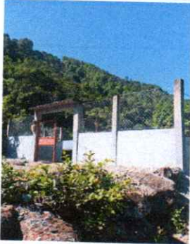
FOTO 1. Reparación de muro perimetral de block con malla galvanizada, soleras intermedias y columnas.
