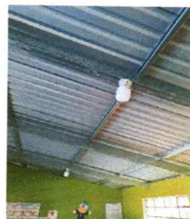
FOTO 8. Sustitución de lámparas en las aulas.
