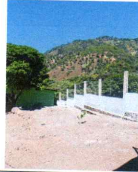
FOTO 2. Reparación de muro perimetral de block con malla galvanizada, soleras intermedias y columnas.
