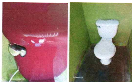
FOTO 10. Sustitución de accesorios de inodoro.
