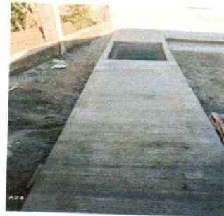
FOTO 6. Reparación de cuneta de concreto.
