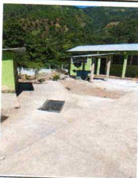
FOTO 5. Reparación de cuneta de concreto.
