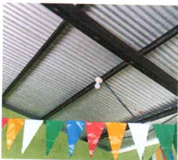
FOTO 9. Reparación de cableado eléctrico.
