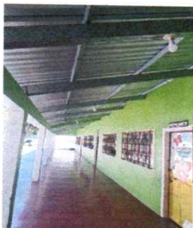
FOTO 7. Sustitución de focos ahorradores en corredores.
