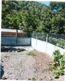
FOTO 3. Reparación de malla galvanizada.
