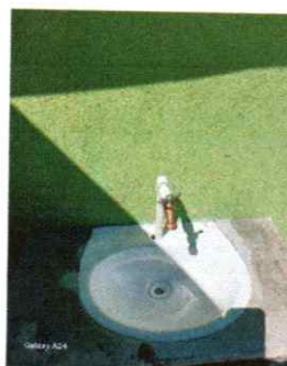
FOTO 12. Sustitución de llaves de chorro.
