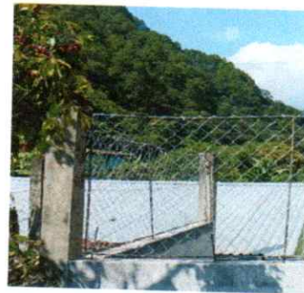
FOTO 4. Reparación de malla galvanizada.
