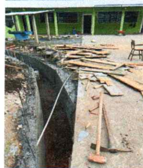
FOTO 6. Reparación de cuneta de concreto.
