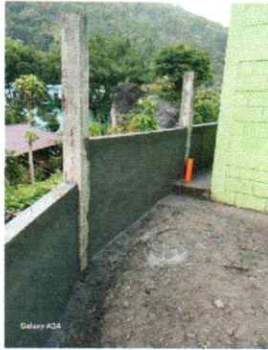
FOTO 7. Reparación de muro perimetral de bloques con malla galvanizada, soleras intermedias y columnas.
