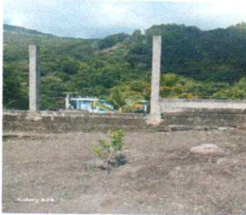
FOTO 1. Reparación de muro perimetral de block con malla galvanizada soleras intermedias y columnas.
