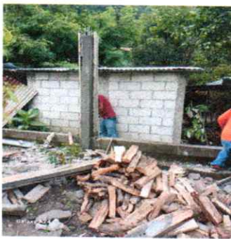
FOTO 3. Reparación de malla galvanizada.
