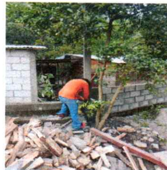
FOTO 4. Reparación de malla galvanizada.
