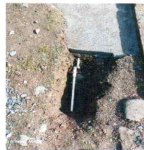
FOTO 12. Sustitución de tubería lineal principal.
