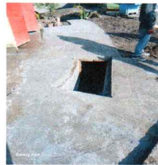
FOTO 8. Reparación de cuneta.
