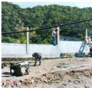
FOTO 9. Reparación de cableado eléctrico.
