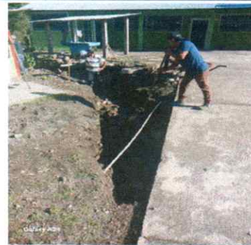
FOTO 10. Sustitución de tubería principal.
