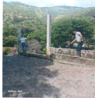
FOTO 2. Reparación de muro perimetral con malla galvanizada, soleras intermedias y columnas.
