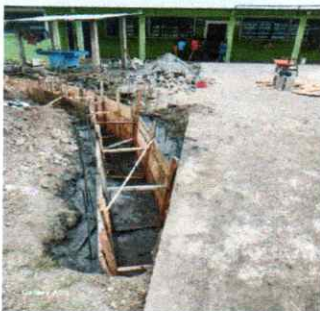
FOTO 5. Reparación de cuneta de concreto.
