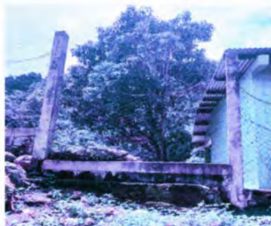
FOTO 2. Reparación de muro perimetral de block con tubo hg y malla galvanizada, soleras intermedias y columnas.
