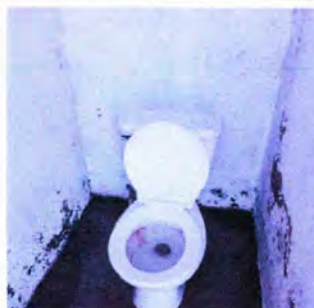
FOTO 10. Sustitución de accesorios de inodoro.
