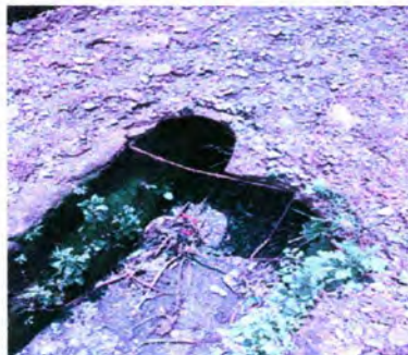
FOTO 6. Reparación de cunet de concreto.
