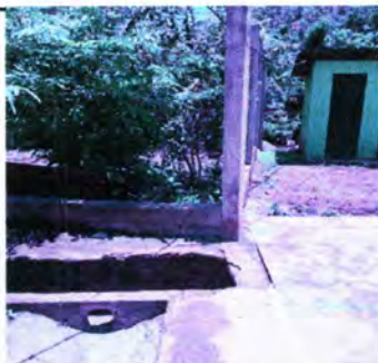
FOTO 5. Reparación de cuneta de concreto.
