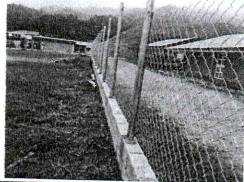
Foto 4: REPARACIÓN DE MURO PERIMETRAL CON TUBO HG Y MALLA
