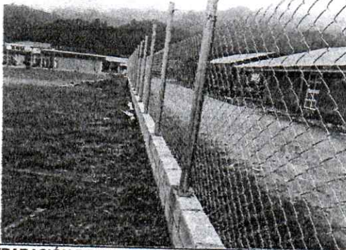
Foto 1: REPARACIÓN DE MURO PERIMETRAL CON TUBO HG Y MALLA
