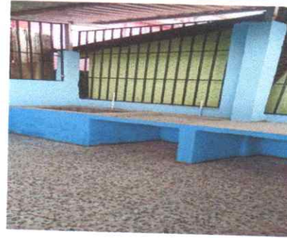
Foto 2: Mesa de concreto, lava trastes y tanque terminados juntamen te radeado de los balcones.
