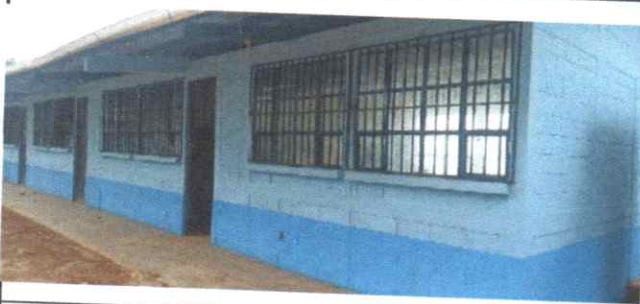
Foto 5: Las aulas ya cuentan con balcones para mayor seguridad
