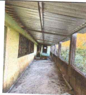
Foto 6: el pasillo a los baños ta cuenta con piso de torta de concreto y colocación de techo con estructuras metálicas.
