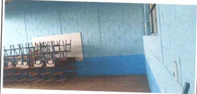
Foto 4: Los muros interiores y exteriores ya estan pintados
