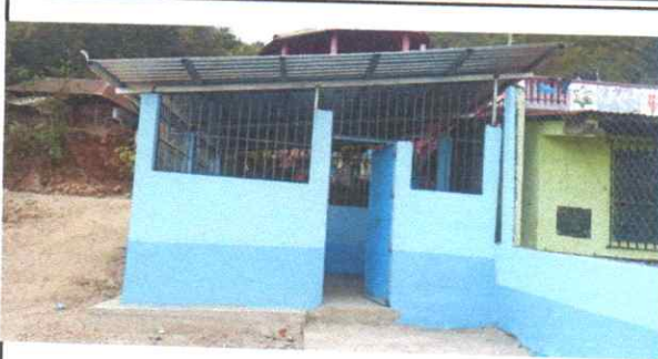
Foto 1: la cosina se encuentra terminada con techo, reppello y pintura en las paredes dentro y fuera.
