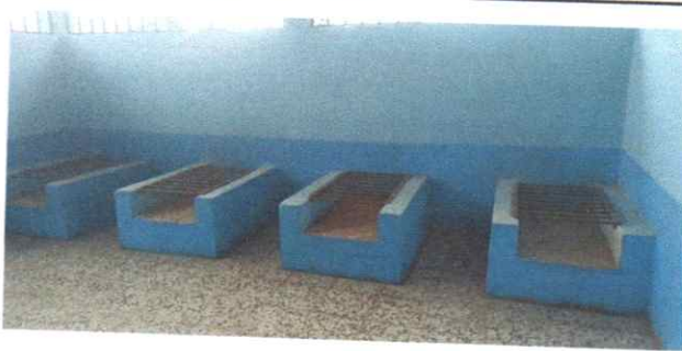
Foto 3: La cocina ya cuenta con el mosaico granito y los fogoes terminados con parrillas de huerro.
