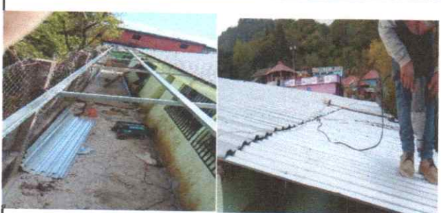
Foto 6: colocación de techo y piso en el pasillo hacia los baños.
