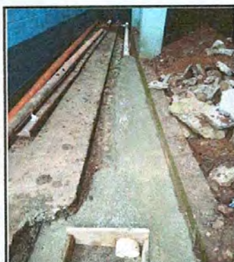
Foto 3: Reparación de drenaje.
