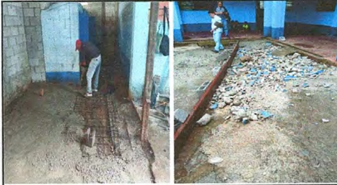
Foto 7: Reparación de piso.
