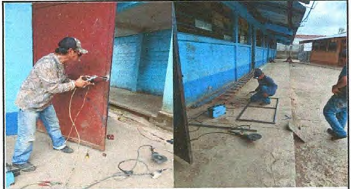
Foto 8: Reparación de puertas.
