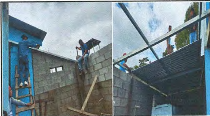
Foto 9: Reparación de techo.
