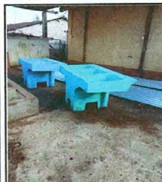
Foto 5: Instalación de pila.
