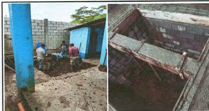
Foto 11: Reparación de cisterna.
