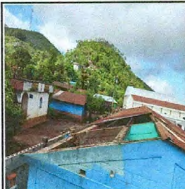
Foto 1: Reparación de lámina.
