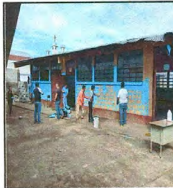
Foto 4: Aplicado de pintura.
