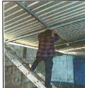
Foto 6: Reparación de sistema eléctrico.
