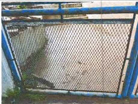
Foto 3: Mantenimiento a portones de metal.
