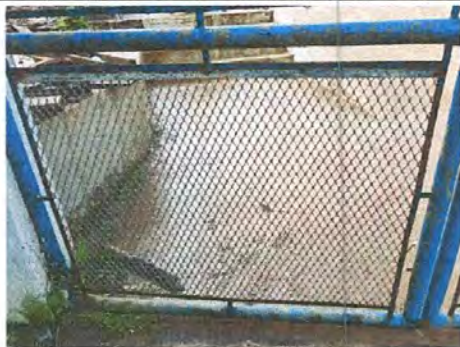
Foto 3: Mantenimiento a portones de metal.
