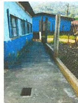
Foto 4: Reparación de planchas de concreto de patio.
