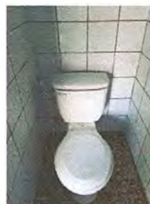
Foto 2: Sustitución de inodoror
