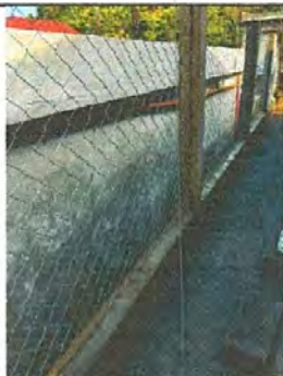
Foto 5: Reparación de muro perimetral con block.
