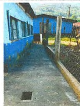
Foto 4: Reparación de planchas de concreto de patio.
