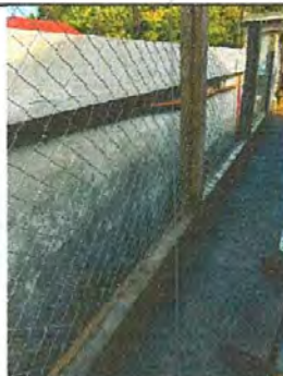
Fot 5: Reparación de muro perimetral con block.
