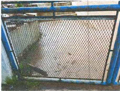
Foto 3: Mantenimiento a portones de metal.
