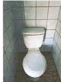
Foto 2: Sustitución de inodoror
