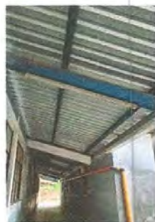
Foto 1: Sustrucción de canal de pvc con soportes y accesorios.
