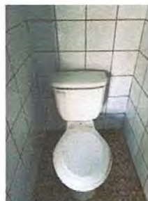
Foto 2: Sustitución de inodoror
