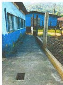
Foto 4: Reparación de planchas de concreto de patio.
