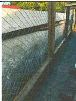
Foto 5: Reparación de muro perimetral con block.
