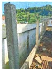
Fot 5: Reparación de muro perimetral con block.
