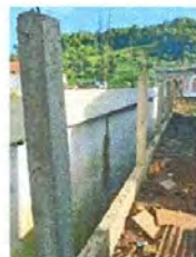
Foto 5: Reparación de muro perimetral con block.
