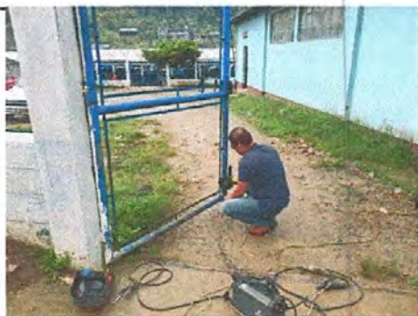
Foto 3: Mantenimiento a portones de metal.
