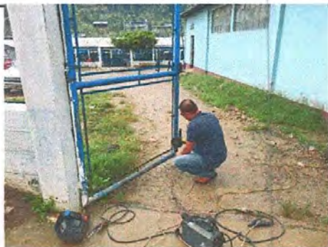
Foto 3: Mantenimiento a portones de metal.
