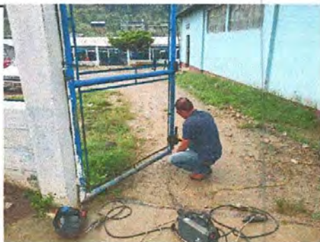
Foto 3: Mantenimiento a portones de metal.
