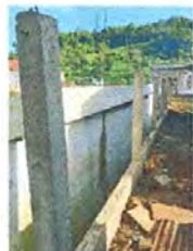
Fot 5: Reparación de muro perimetral con block.
