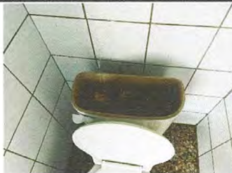
Foto 2: Sustrucción de inodoror
