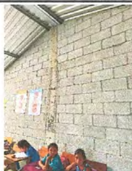
Foto 6: Sellado de grietas y fisuras en muros
