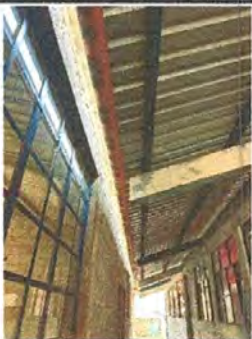
Foto 1: Sustrucción de canal de pvc con soportes y accesorios.
