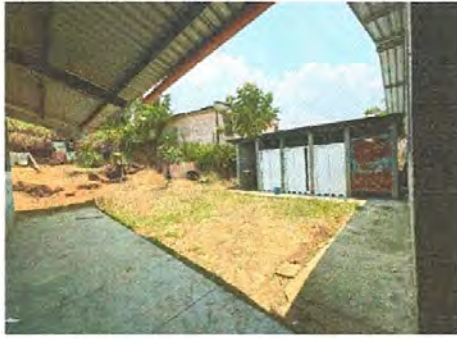
Foto 4: Reparación de planchas de concreto de patio.
