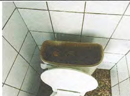
Foto 2: Sustitución de inodoros
