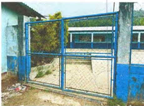
Foto 3: Mantenimiento a portones de metal.
