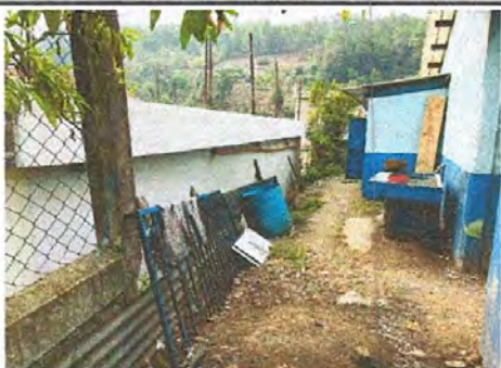
Foto 5: Reparación de muro perimetral con block.
