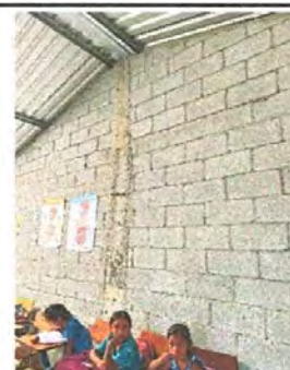
Foto 6: Sellado de grietas y fisuras en muros
