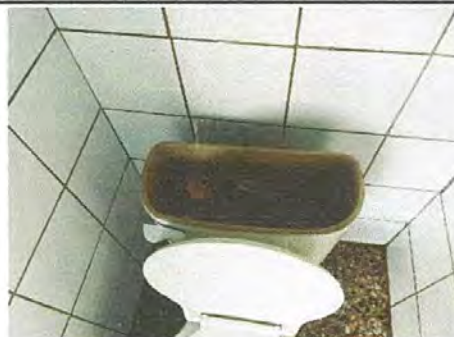
Foto 2: Sustitucion de inodoror
