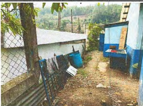
Foto 5: Reparación de muro perimetral con block.
