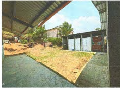
Foto 4: Reparación de planchas de concreto de patio.
