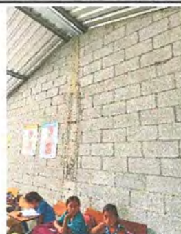
Foto 6: Sellado de grietas y fisuras en muros
