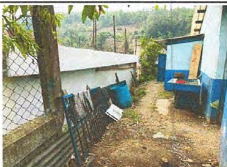
Fot 5: Reparación de muro perimetral con block.
