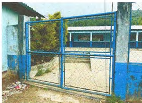
Foto 3: Mantenimiento a portones de metal.
