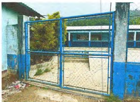
Foto 3: Mantenimiento a portones de metal.
