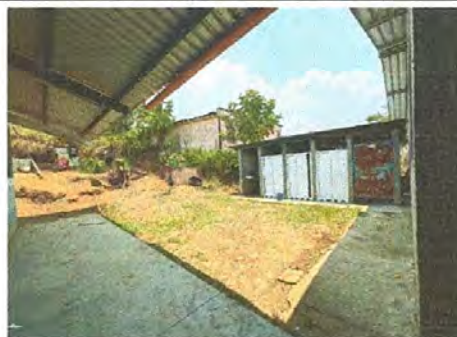
Foto 4: Reparación de planchas de concreto de patio.
