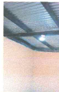
foto 6: Reparación de sistema eléctrico, finalizado, interior de un módulo
