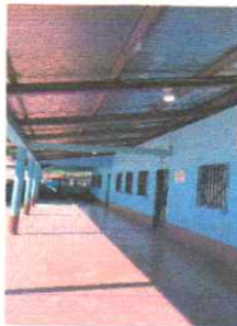
foto 5: Reparación de sistema eléctrico , finalizado , un corredor de aulas
