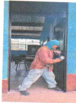
Foto 4: puerta. Avance de puesta de puertas
