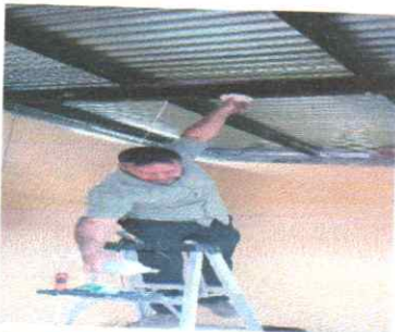
foto 5: avance de reparación de sistema eléctrico
