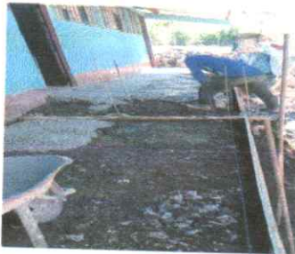
Foto 3: piso, avance de torta de cemento .
