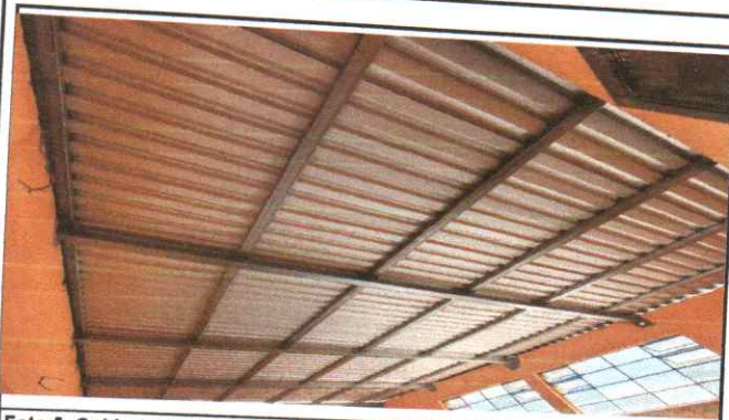
Foto 5: Cubierta de lámina y estructura de techo
