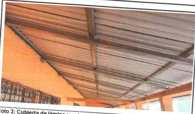
Foto 3: Cubierta de lámina y estructura de techo
