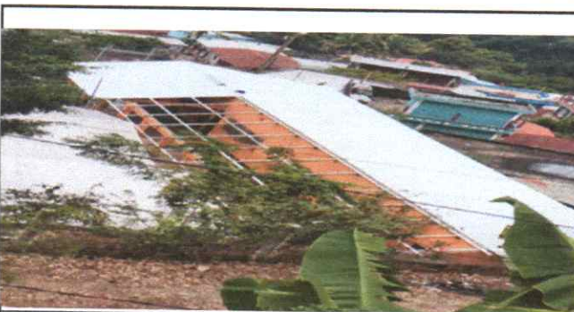
Foto 5: Cubierta de lámina y estructura de techo
