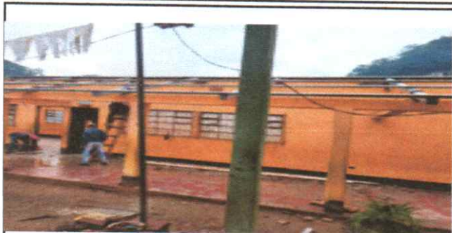
Foto 1: Cubierta de lámina y estructura de techo
