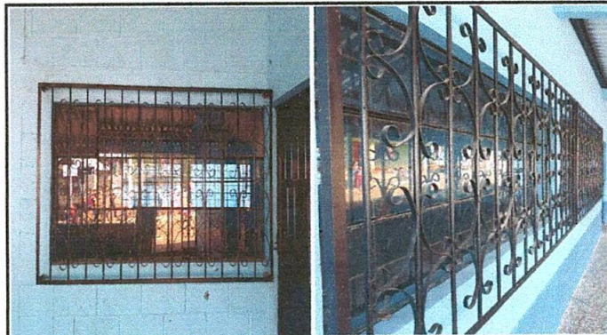
Foto 4: Reparación total de ventanas.
