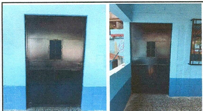
Foto 3: Reparación total de puertas.
