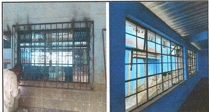
Foto 4: Reparación de ventanas.
