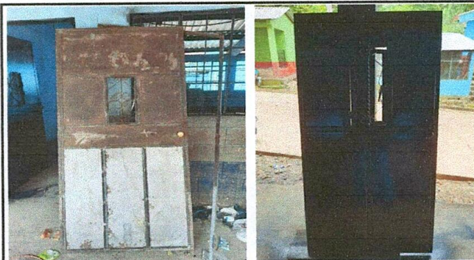
Foto 3: Reparación de puertas.
