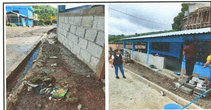
Foto 6: Reparación de muro perimetral.
