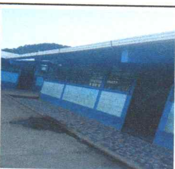
Foto 5: Se sustituyo canal de metal por canal de PVC
