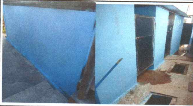
Foto 7: Se repello 7 baños y una duchas y pintado.
