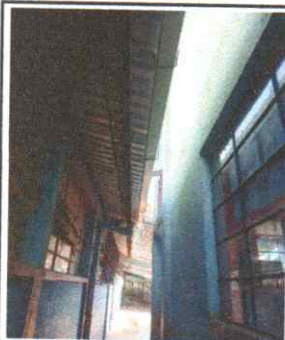
Foto 5: Se sustituyo canal de metal por canal de PVC
