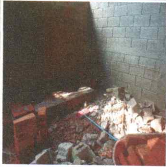
Foto1: Reparacion de cocina.
