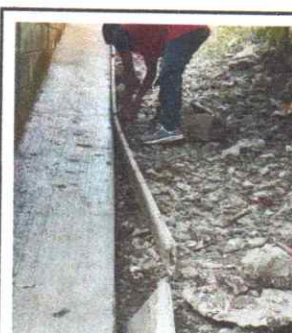
Foto 6: Reparacion de banquetas de concreto
