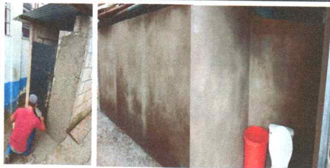
Foto 7: Repello paredes de baños.
