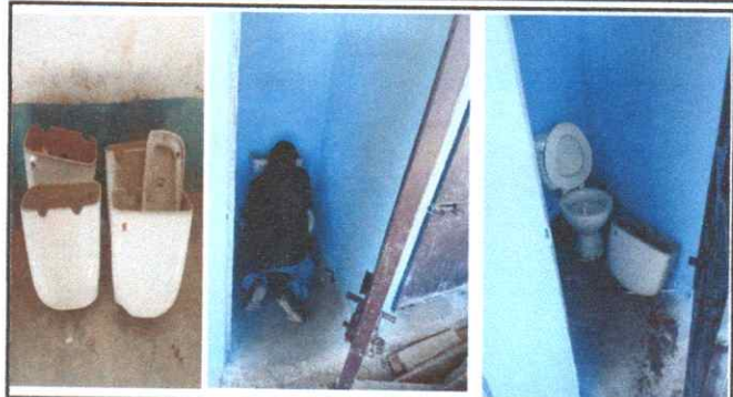
Foto 8: sustitucion de accesorios para baños.
