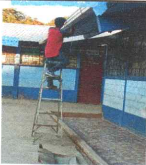
Foto 5: Sustitucion de canales de PVC
