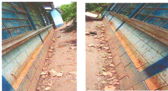
Foto 7: Reparacion de banqueta de concreto
