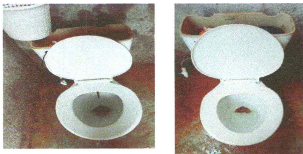
Foto 9: Sustitución de accesoris para baños.
