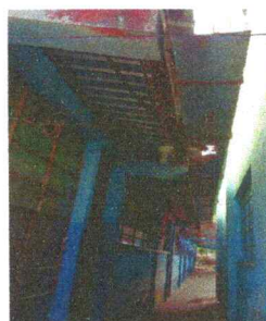
Foto 6: sustitucion de canales de PVC.
