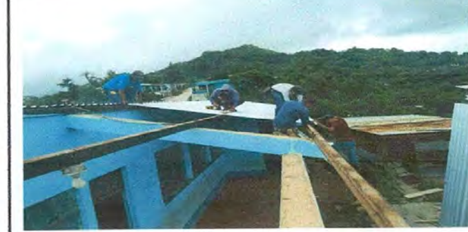
Foto 12: Cambio de techo de lámina
