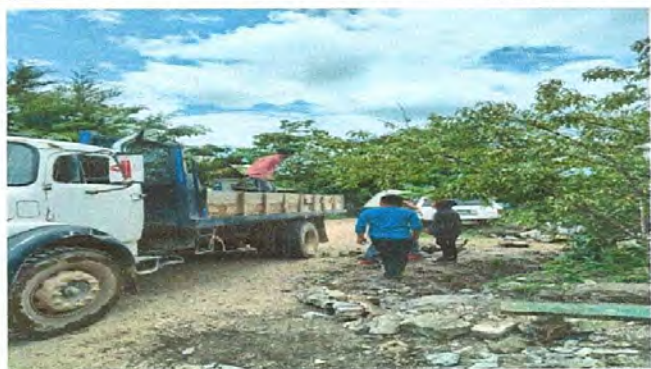
Foto 1: Recepción de materiales
