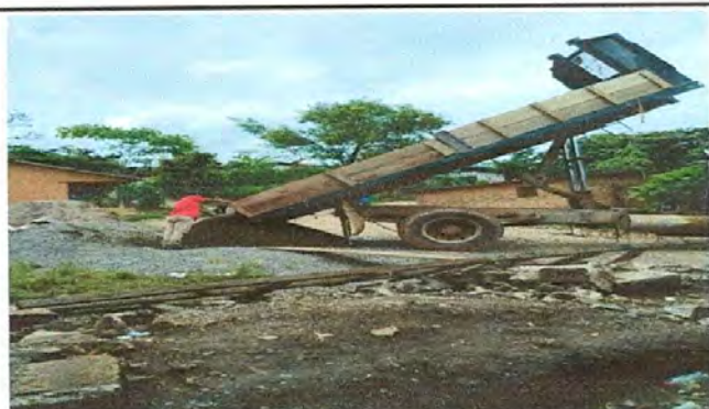
Foto 3: Recepción de materiales
