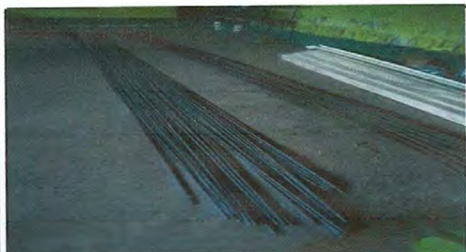
Foto 5: Recepción de materiales
