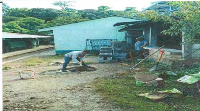
Foto 7: Inicio de trabajo
