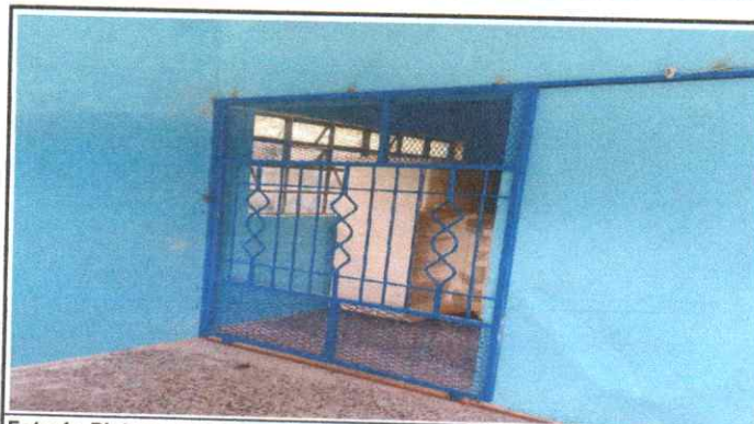
Foto 4: Pintura en muros exteriores e interiores.
