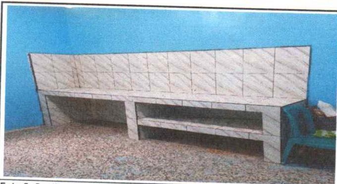
Foto 5: Sustrucción de azulejo en muebles de cocina.
