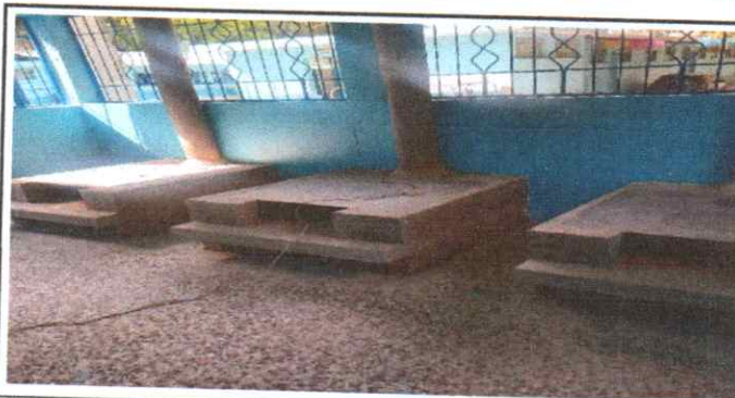
Foto 6: Sustrucción de planchas de metal de 3 hornillas.
