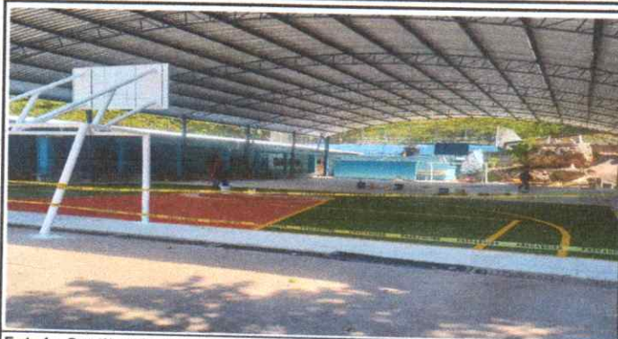
Foto1: Sustrucción de planchas de concreto de patio, cancha polideportiva
