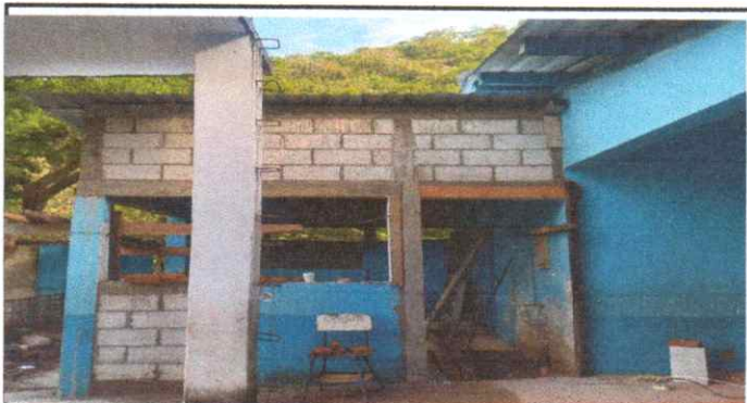
Foto 3: Sustitución de ventana balcon de metal.
