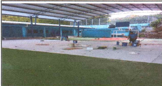
Foto 1: Sustitución de planchas de concreto de patio, cancha polideportiva
