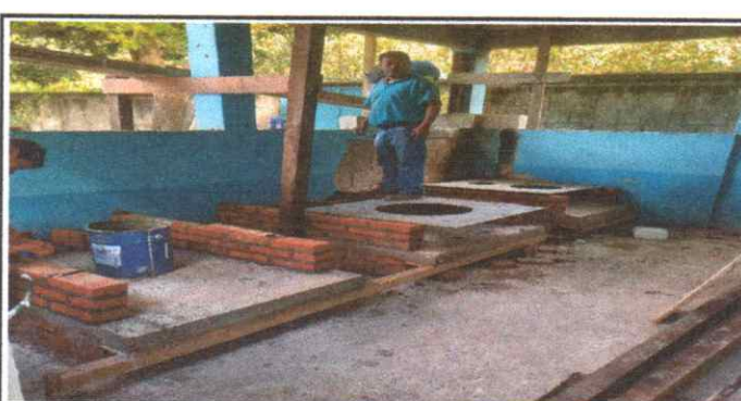
Foto 6: Sustitución de planchas de metal de 3 hornillas.
