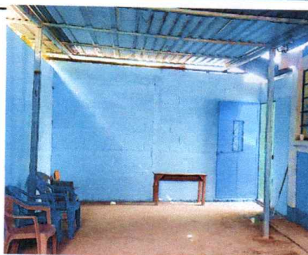
Foto 5: Sustrucción de estructura de soporte de madera, por metal.
