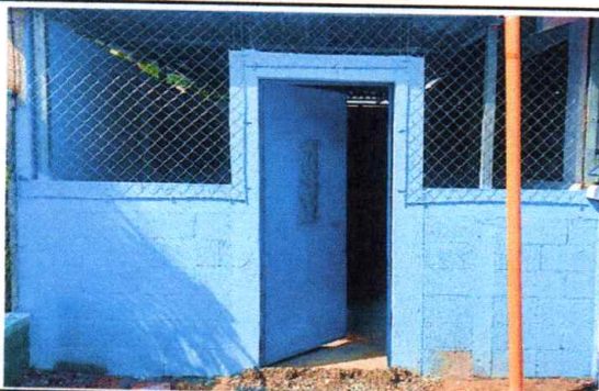
Foto 2: Colocación de media pared con ventanas de maya metálica y piso de concreto.
