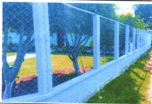
Foto 1: Sustrucción de postes de madera por columnas de cemento con tres hiladas de block
