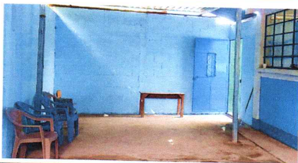
Foto 3: Reparación de piso de torta de cemento.
