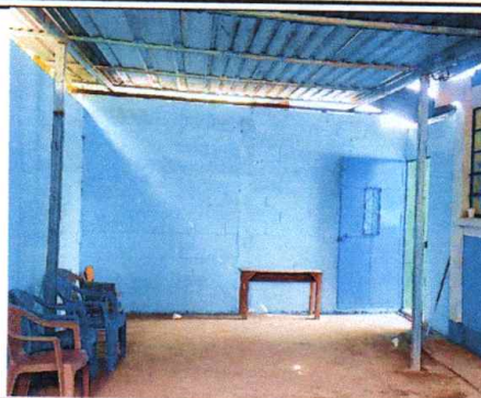
Foto 4: Sustrucción de Lámina, por lámina troquelada calibre 26
