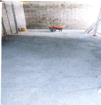
FOTO 3: Reparación de piso de torta de cemento.
