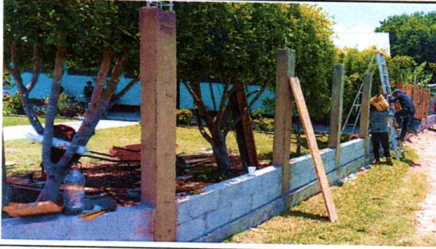
Foto 1: Sustitución de postes de madera por columnas de cemento con tres hiladas de block
