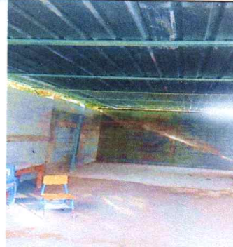
Foto 4: Sustitución de Lámina, por lámina troquelada calibre 26
