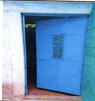
Foto 6: Sustitución de puertas de metal.
