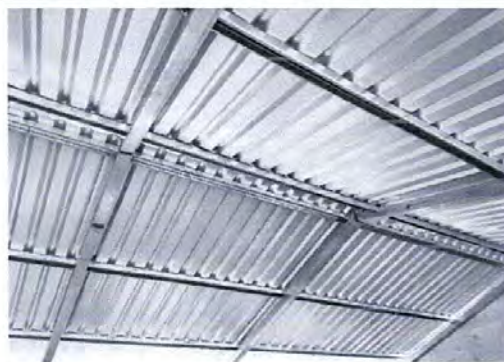
Foto 2: sustitución de estructura de soporte
