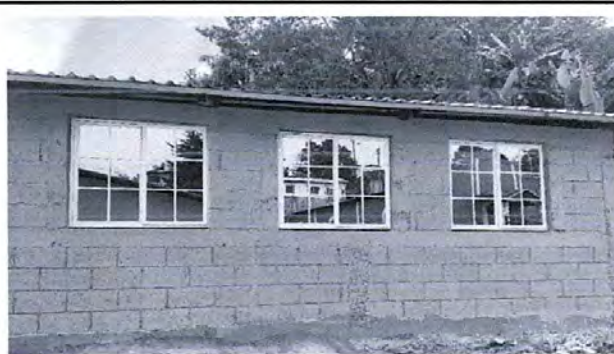
Foto 4: sustitución de ventanas de madera por metal
