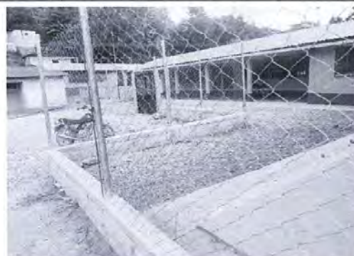
Foto 8: reparación de muro perimetral
