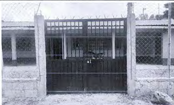
Foto 7: mantenimiento a porton
