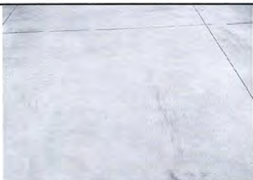
Foto 5: sustitución de piso de torta
