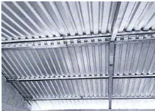
Foto 1: sustitución de lámina por lámina troquelada calibre 26
