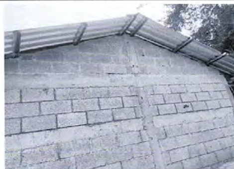
Foto 6: reparación de pared
