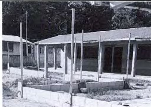
Foto 7: mantenimiento a porton
