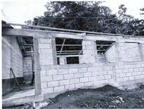
Foto 2: sustitución de estructura de soporte
