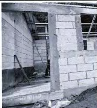
Foto 3: sustitución de puerta
