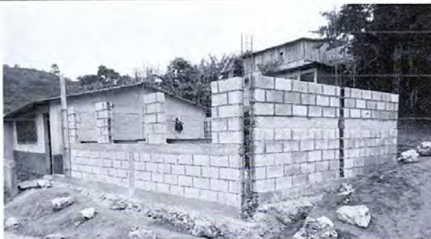
Foto 6: reparación de pared
