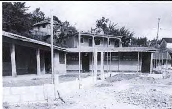
Foto 8: reparación de muro perimetral
