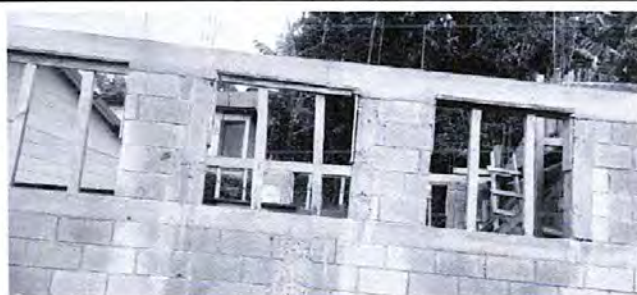
Foto 4: sustitución de ventanas de madera por metal
