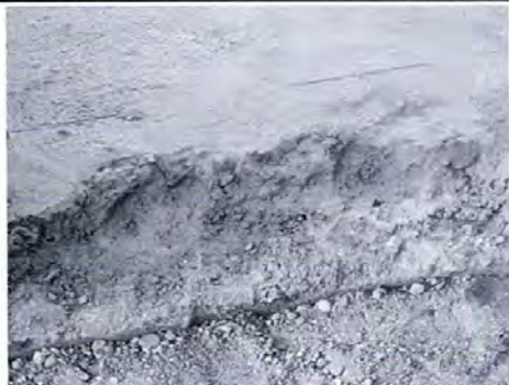
Foto 5: sustitución de piso de torta
