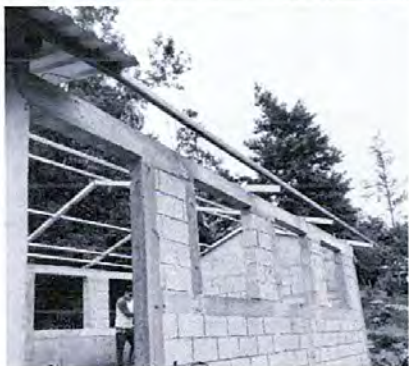
Foto 1: sustitución de lámina por lámina troquelada calibre 26
