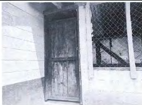
Foto 3: sustitución de puerta
