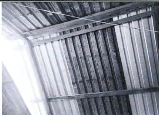
Foto 1: sustitución de lámina por lámina troquelada calibre 26
