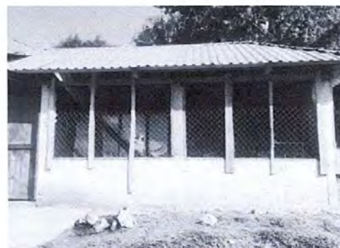
Foto 4: sustitución de ventanas de madera por metal
