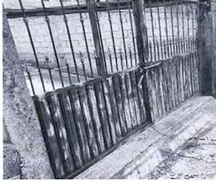
Foto 7: mantenimiento a porton
