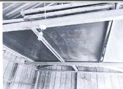
Foto 2: sustitución de estructura de soporte
