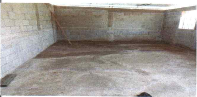
Foto 5: Torta de concreto
