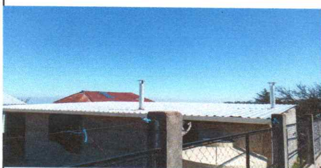
Foto 1: Techo de lamina troquelada
