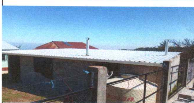
Foto 2: techo de lamina troquelada
