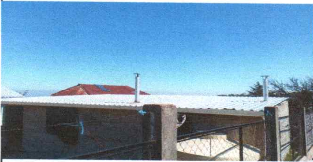
Foto 1: Techo de lamina troquelada
