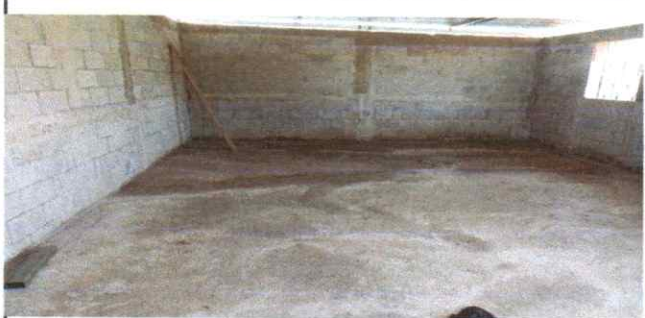
Foto 5: Torta de concreto
