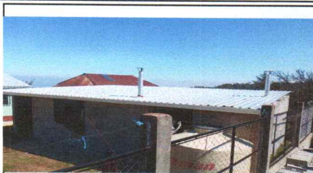
Foto 2: techo de lamina troquelada
