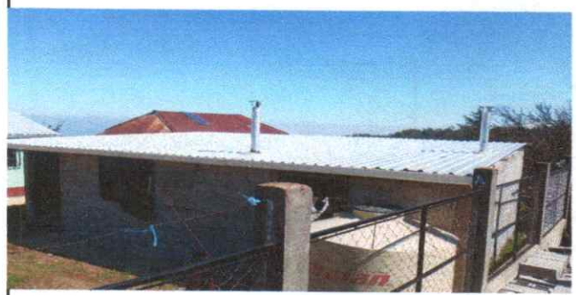
Foto 2: techo de lamina troquelada
