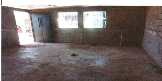
Foto 6: Torta de concreto
