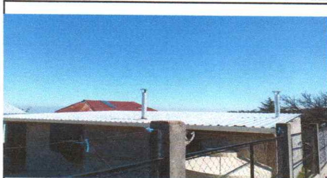
Foto 1: Techo de lamina troquelada
