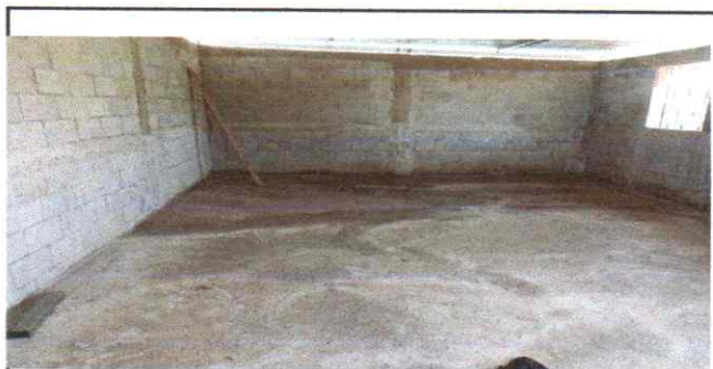
Foto 5: Torta de concreto
