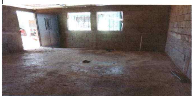
Foto 6: Torta de concreto
