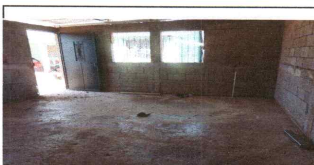
Foto 6: Torta de concreto
