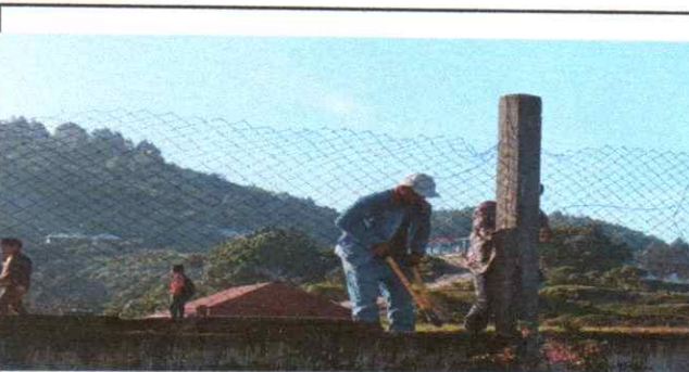
Foto 5: Reparacion de muro perimetral
