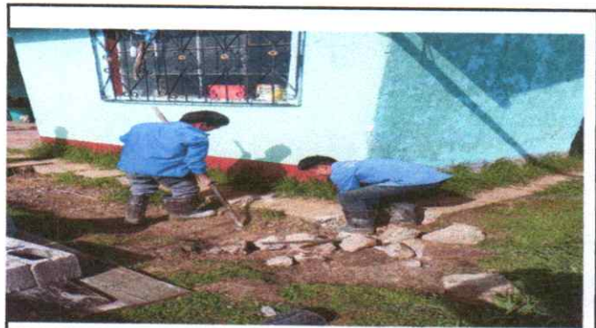
Foto 4: Reparacion de banquetas
