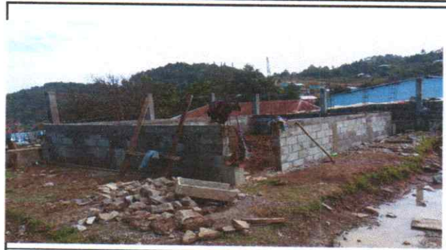
Foto 2: Reparación de muros de cocina
