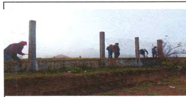
Foto 6: Reparación de muro perimetral
