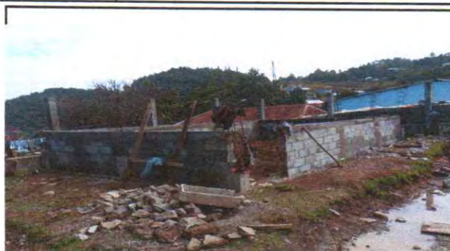
Foto 2: Reparación de muros de cocina
