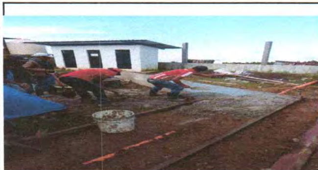
Foto 3: Reparación de Baquetas
