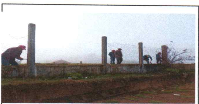
Foto 6: Reparacion de muro perimetral
