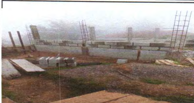
Foto 1: Reparación de muros de cocina
