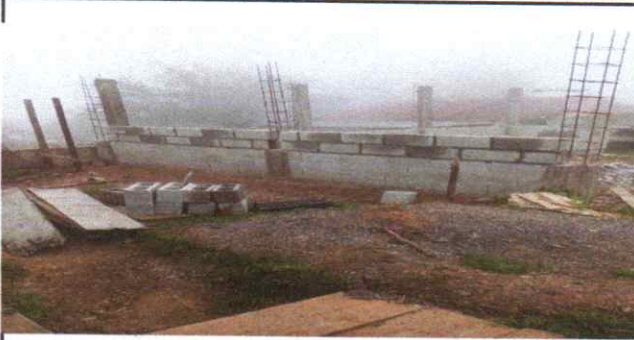
Foto 1: Reparacion de muros de cocina
