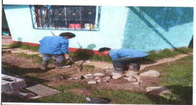
Foto 4: Reparación de banquetas
