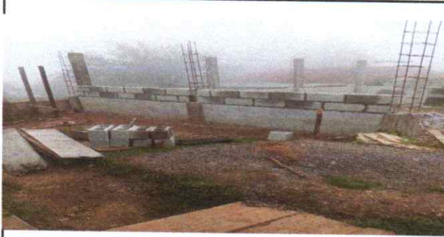
Foto 1: Reparación de muros de cocina
