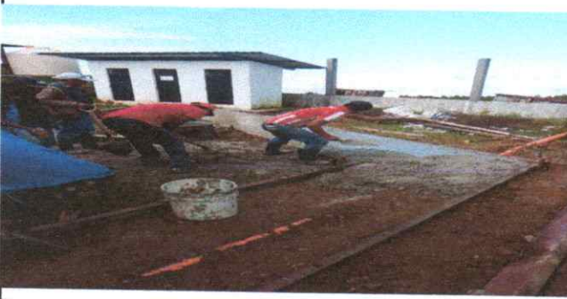
Foto 3: Reparación de Baquetas
