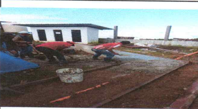
Foto 3: Reparación de Baquetas
