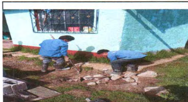
Foto 4: Reparación de banquetas
