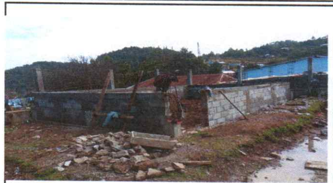
Foto 2: Reparacion de muros de cocina
