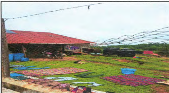
Foto 2: malla del muro perimetral
