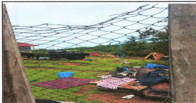
Foto 1: malla del muro perimetral
