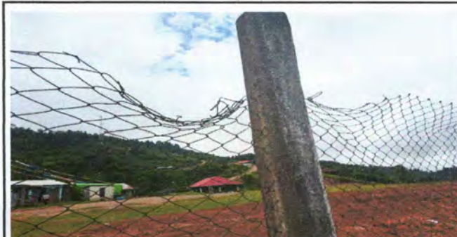
Foto 4: malla del muro perimetral
