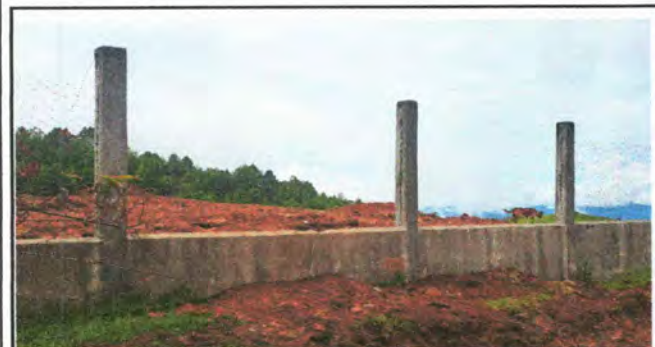
Foto 5: malla del muro perimetral
