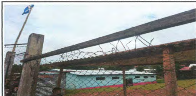
Foto 6: malla del muro perimetral
