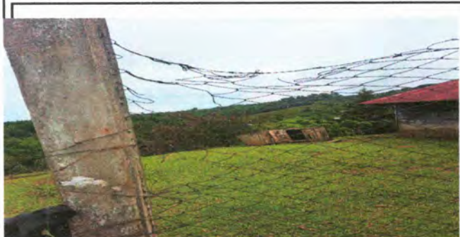
Foto 3: malla del muro perimetral
