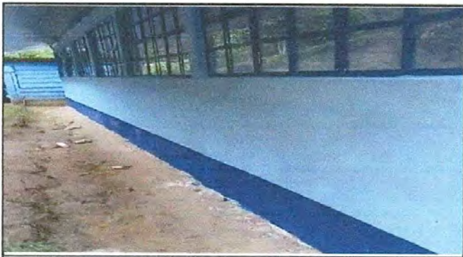
Foto 3: Muro perimetral en malas condiciones.
