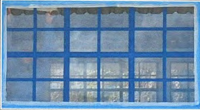
Foto: 7 Sustitución de estructura de metal de ventana
