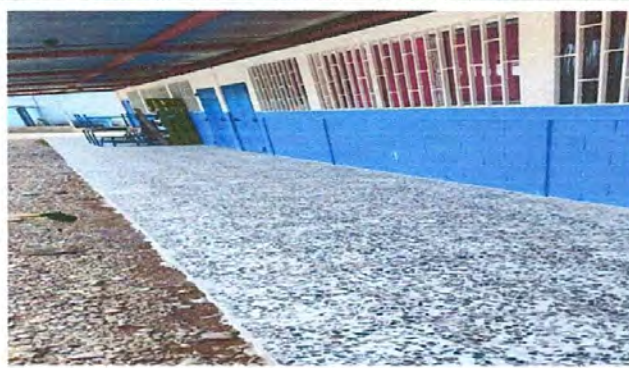
Foto 2: Sustitución de piso de granito
