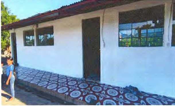
Foto 7: Repello en Muro
