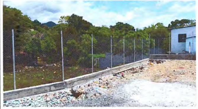
Foto 8: Reparación de Muro de Contención
