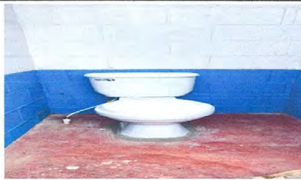
Foto 4: Sustitución de Inodoro.
