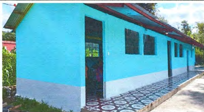
Foto 3: Pintura en Muros exteriores e interiores
