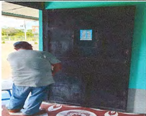
Foto1: Puertas de Metal
