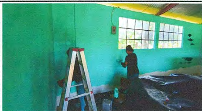
Foto 3: Pintura en Muros exteriores e interiores
