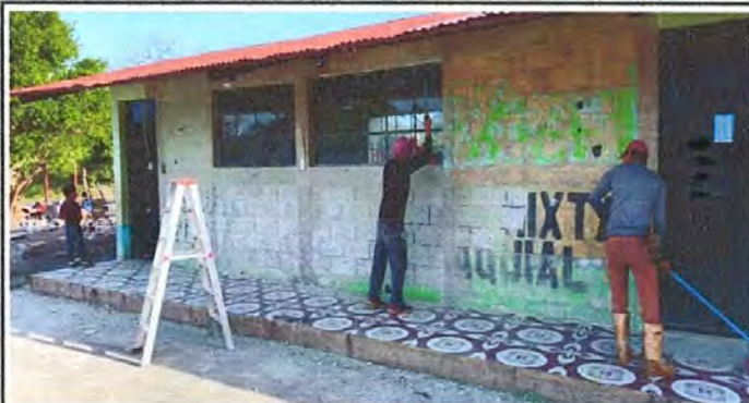
Foto 7: Repello en Muro
