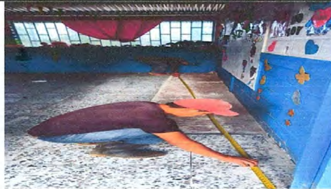
Foto 2: Sustitución de piso de granito
