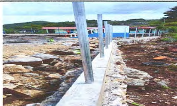
Foto 8: Reparación de Muro de Contención
