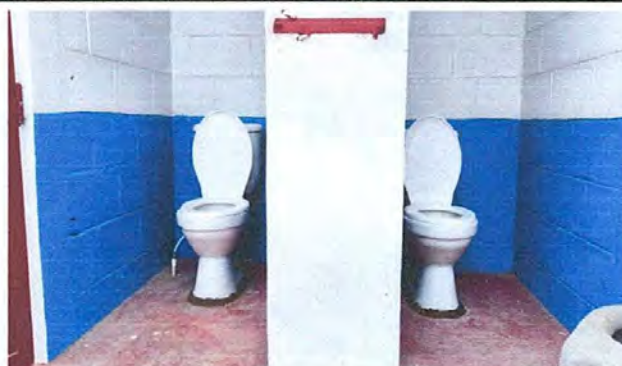
Foto 4: Sustitución de Inodoro
