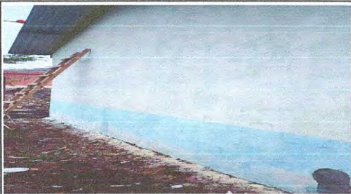
Foto 3: Pintura en Muros exteriores e interiores.
