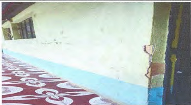
Foto 7: Repello en Muro
