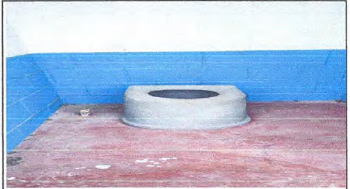
Foto 4: Sustitución de Inodoro.
