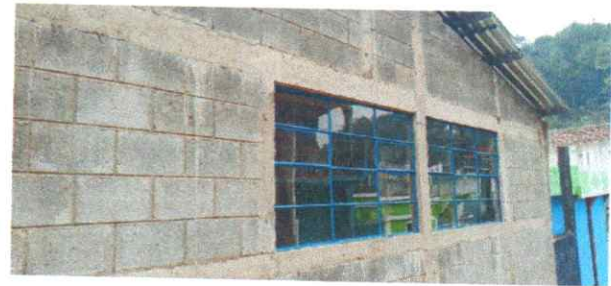
Foto 4: Sustitucion ventanas de metal .
