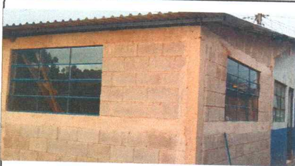
Foto 3: Sustitucion ventanas de metal.
