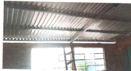
Foto 6: Sustitucion lamina por lamina / sustitucion estructura de soporte.
