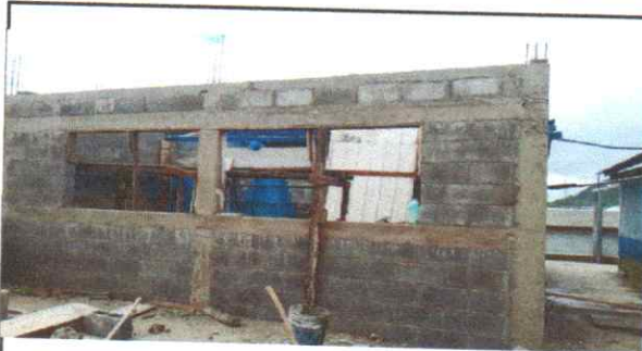
Foto 5: Mejoramiento de pared
