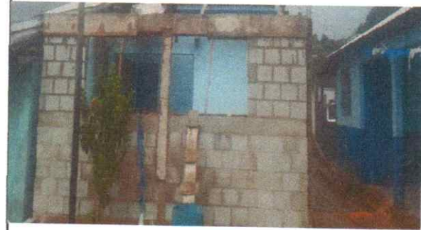
Foto 2: Mejoramiento de pared.
