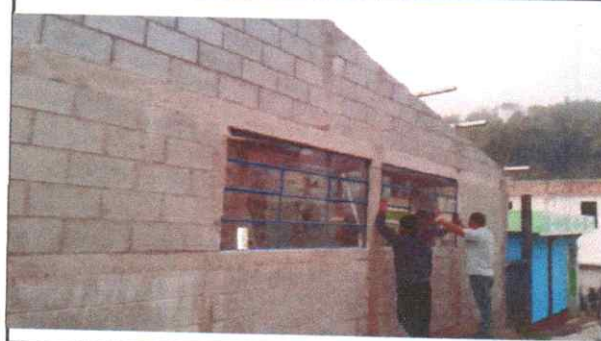
Foto 4: Sustitucion ventanas de metal .
