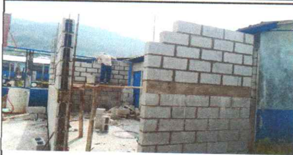
Foto 1: Mejoramiento de pared .
