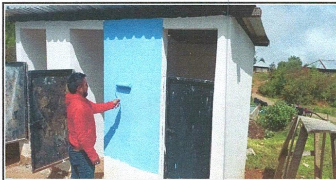
Foto 5: Reparación de sanitarios.
