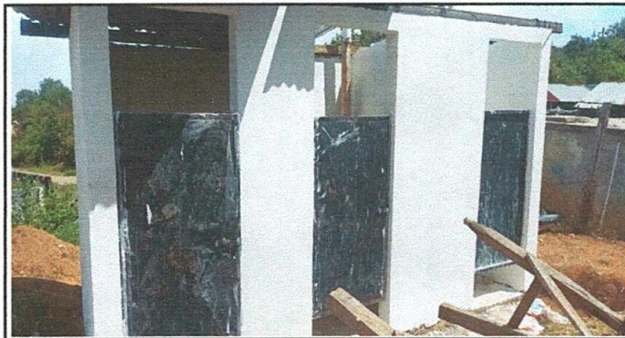
Foto 6: Reparación de sanitarios.
