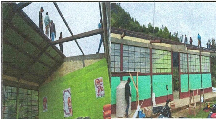
Foto 1: Reparación de techo.
