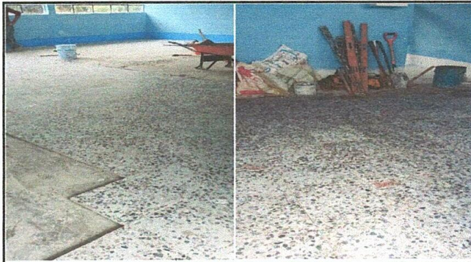
Foto 2: Reparación de piso.
