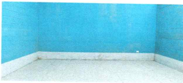
Foto 3: Sustitución de piso cerámico
