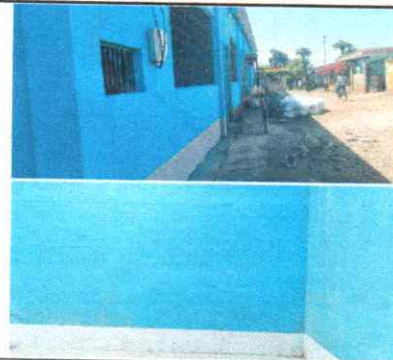
Foto 4: Pintura en muros exteriores e interiores
