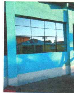
Foto 2: Sustitución de ventana de madera por metal mas vidrio
