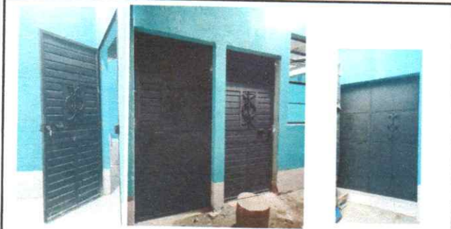
Foto1: Sustitución de puertas y portón de metal
