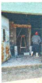
Foto 5: Sustitución de paredes de madera por muro de block
