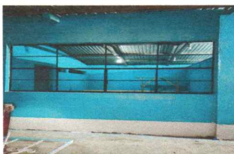
Foto 2: Sustitución de ventana de madera por metal mas vidrio
