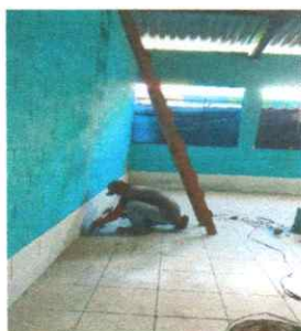
Foto 3: Sustitución de piso cerámico
