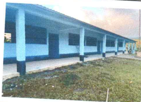
Foto 6: pintura en muros en interiores y exteriores
