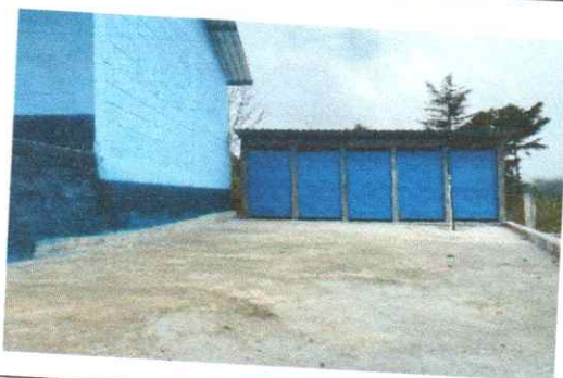
Foto 9: reparación de plancha de patio
