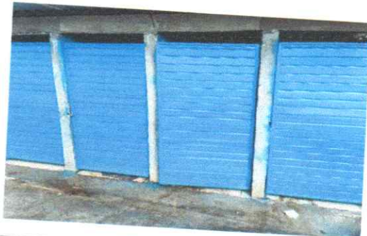
Foto 7: Lijado y pintado en servicios sanitarios
