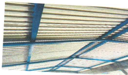
Foto 2: estructura de techo
