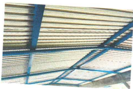
Foto1: colocación de lámina
