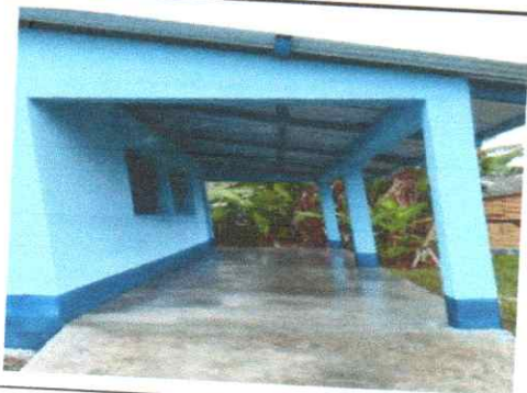
Foto 5: piso de torta de concreto
