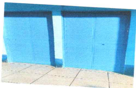
Foto 3: Mantenimiento de puertas de metal
