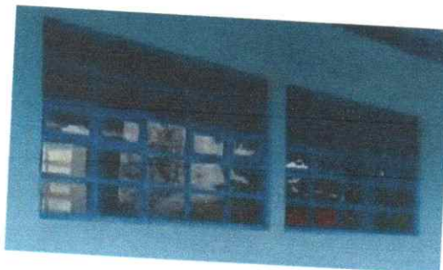
Foto 8: cambio de vidrios y mantenimiento de estructuras de ventanas
