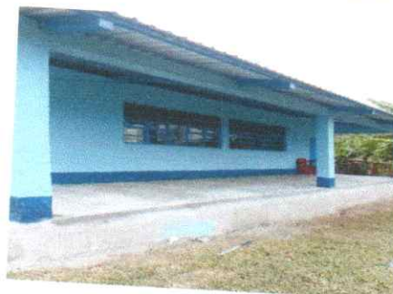
Foto 10: repello de paredes
