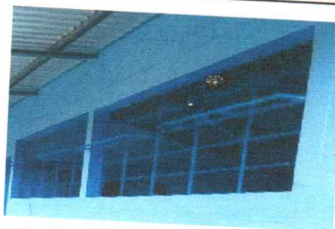
Foto 4: colocación de ventanas
